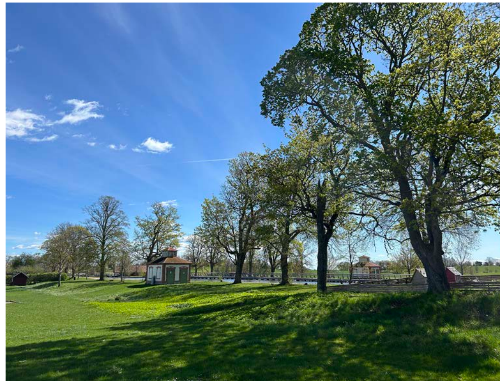
Göta kanal omges av ett öppet parkstråk som skapar distans till omgivande bebyggelse och framhäver kanalen genom samhället. De trädplanterade vallarna med de transformatorstationerna uppe på vallen intill kanalen bidrar till områdets unika karaktär. Träden ger kanalen en rumslig inramning men tillåter samtidigt fri sikt ut över det öppna landskapet på andra sidan vattnet.
