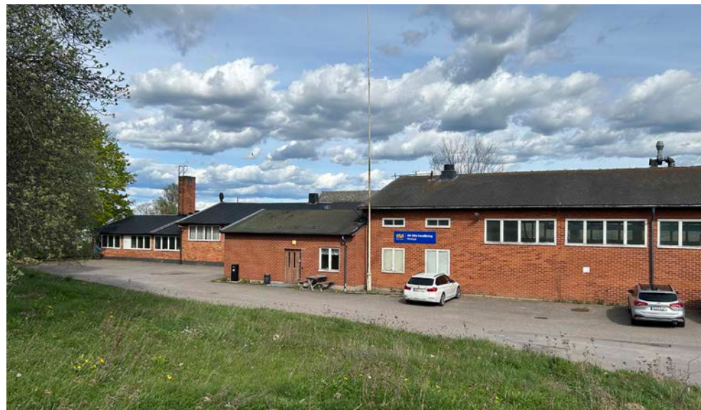
Verkstad/Gamla maskinhallen (byggnad 014B) till vänster i bild och maskinhall/övningshall (byggnad 014C) till höger. Foto Nyréns 2025
