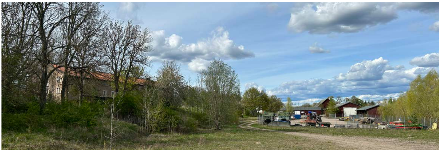
Skolbyggnaderna ligger på en höjd till vänster i bild, idag omgivna av uppvuxen vegetation längs slänten. Till höger syns skolans ekonomibyggnader ligga på rad på den lägre marknivån.
